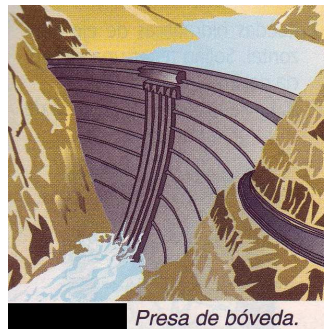
Presa de bóveda.
